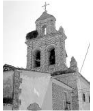
Espadaña de la iglesia.
